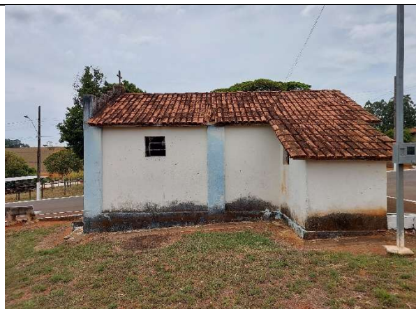
Foto 6: Fachada lateral esquerda. Detalhe para acréscimo e continuidade de cobertura, com uso de telhas cerâmicas tipo capa e canal. Renan Costa, 13 out. 2025.
