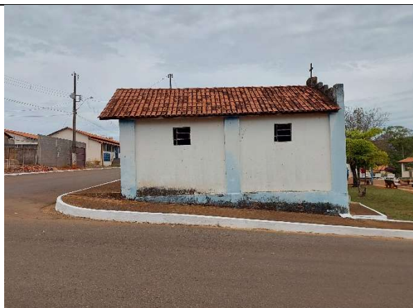
Foto 5: Fachada lateral direita. Detalhe para manchas associadas a infiltrações. Renan Costa, 13 out. 2025.
