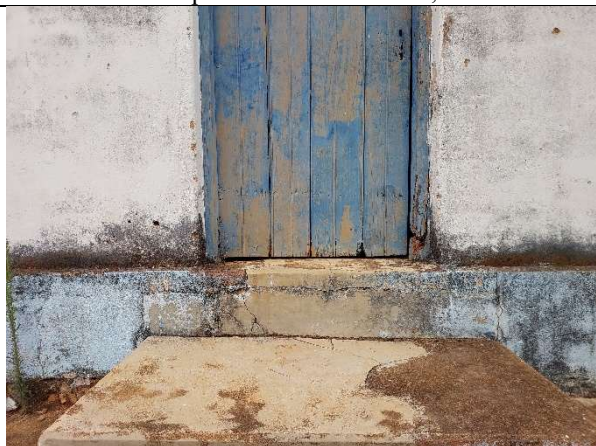
Foto 3: Detalhe para porta de acesso e embasamento, com danos associados a intemperismos. Renan Costa, 13 out. 2025.
