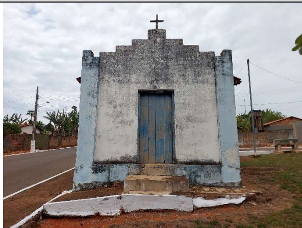
Foto 2: Em aproximação, evidentes danos associados a intemperismos. Renan Costa, 13 out. 2025.
